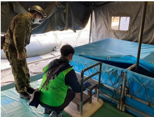
写真⑤(浴室に手すりを設置する様子)
